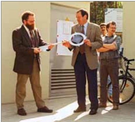
Ein Meilenstein: Inbetriebnahme des Hauptpumpwerks I in Kleinmachnow am 2. Mai 1997
