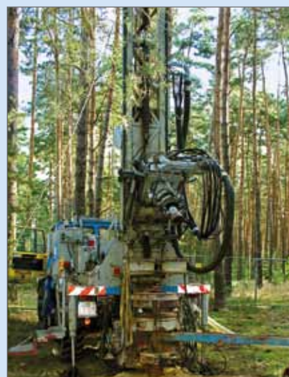
Bohrarbeiten für den Versuchsbrunnen Foto: MWA
