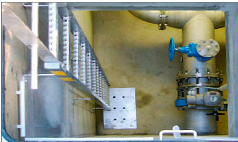
Wasserzählerschacht
