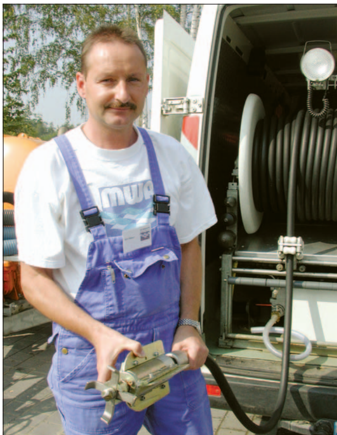
MWA-Mitarbeiter Andreas Büttner mit 120 bar Rohrfräser - Hochdruckreinigungsgerät vor dem Spülwagen
