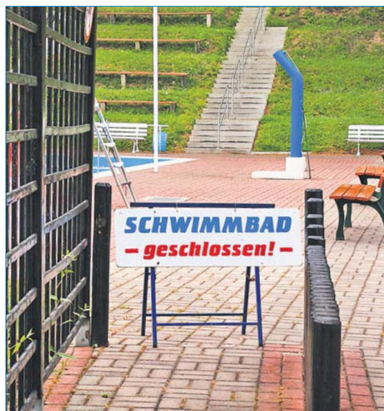
Auch die Großanlagen wie Schwimmbäder unterliegen Wartungsvorschriften wie in Wohngebäuden. © Karl-Heinz Laube/PIXELIO
