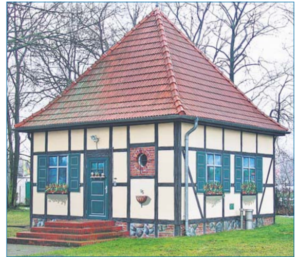
Das Pumpwerk am Schenkendorfer Weg in Teltow wurde wie viele andere in der Region durch kunstvolle Graffiti zu einem Schmuckstück.
