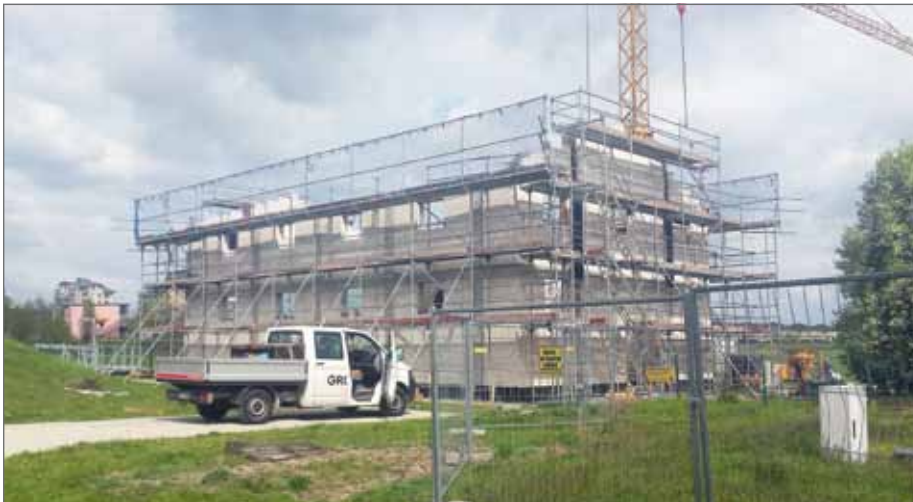
Bau der neuen Filterhalle.
