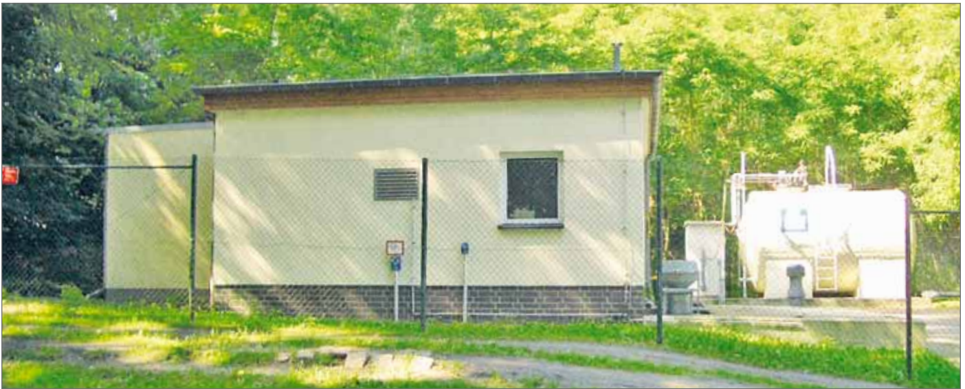
Pumpwerk in Langerwisch
