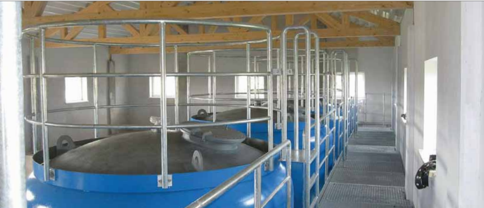
Ausbau des Wasserwerks Teltow – mehr dazu auf Seite 2
