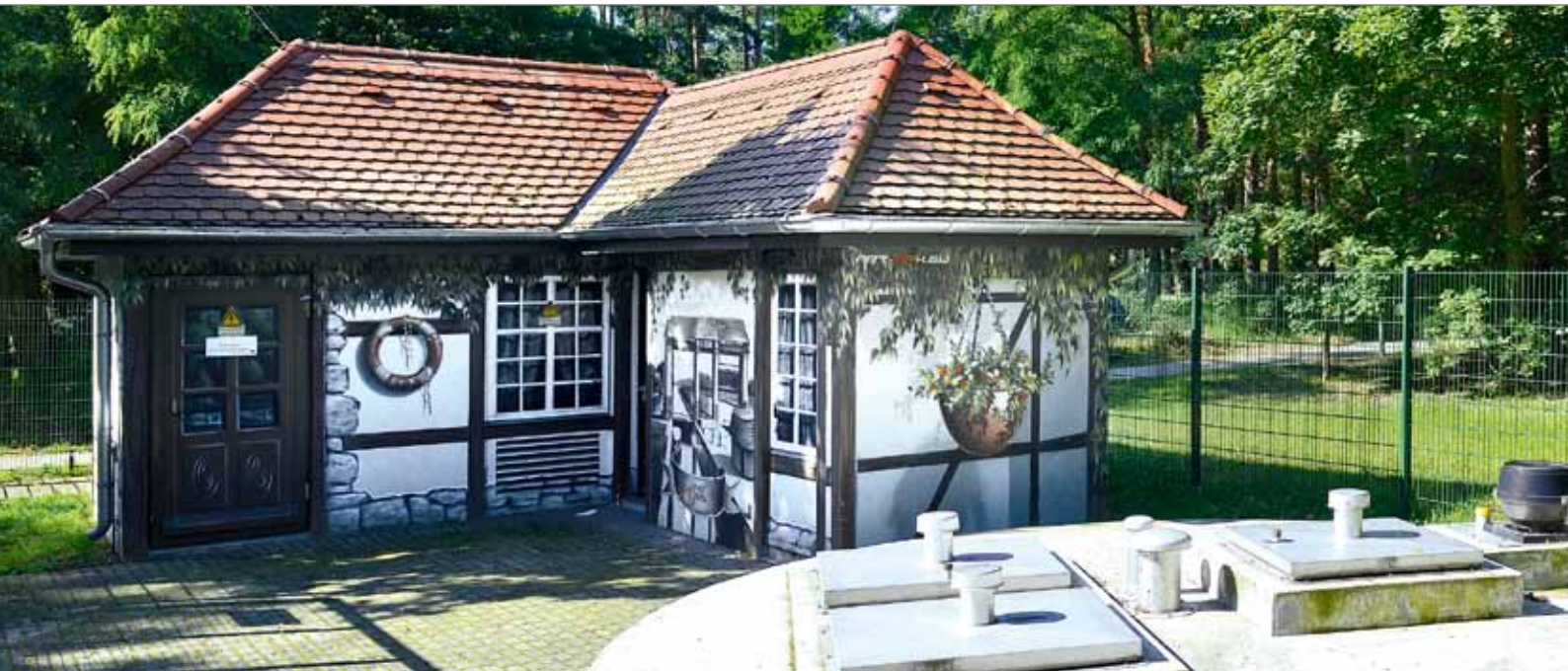
Hauptpumpwerk Stahnsdorfer Damm
