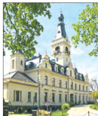
Schloss Güterfelde und die dazu gehörenden Flächen waren bereits vor 1945 für die Trinkwasserver- und Abwasserentsorgung komplett erschlossen worden.
