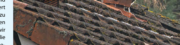
Steigt Nebel aus der Dachentlüftung ist alles ok. Entweicht er aus der Regenrinne ist diese mit der Kanalisation verbunden: eine Ordnungswidrigkeit!
