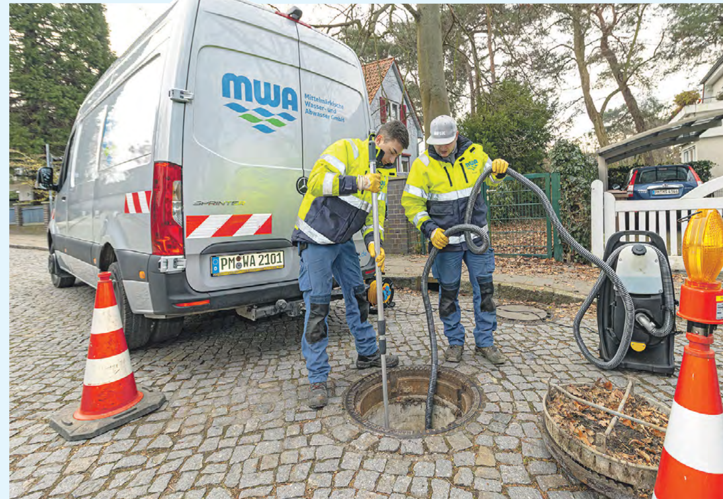
Die MWA-Kanalnetzmonteur Philipp Seidel (r.) und Justin Badstieber bereiten das „Nebeln“ der Kanalisation vor, um mögliche Fehleinleiter auszumachen.
