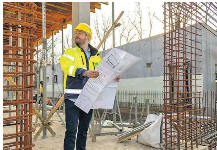
Patrick Koppermann, Ingenieur Siedlungswasserwirtschaft bei der MWA, beim Check des Baufortschrittes am Wasserwerk Kleinmachnow.
