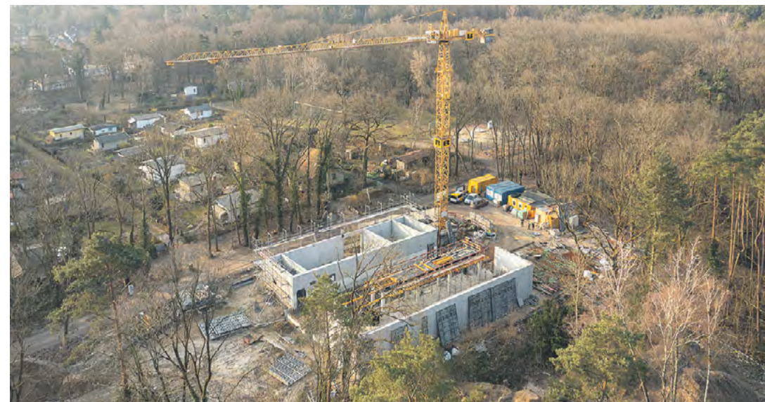
Der Erweiterungsbau wächst langsam in die Höhe – aus der Vogelperspektive gut zu erkennen. Fotos (2): SPREE-PR/Petsch
