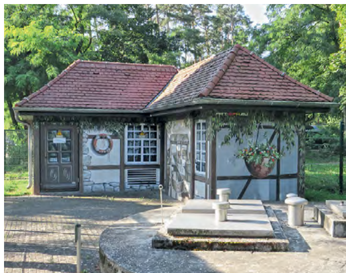
Nahе der fast 120-jährigen Schleuse am Teltowkanal werden am Stahnsdorfer Damm rund 500.000 m 3 Abwasser pro Jahr gepumpt.
