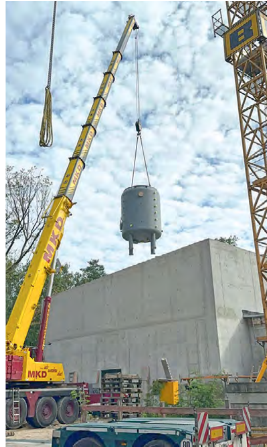
Landeanflug der riesigen Filterkessel in den Erweiterungsneubau des Wasserwerkes – Millimeterarbeit bei höchster Konzentration!
