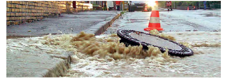
Hier geht gar nichts mehr: Der Kanal ist voll!
