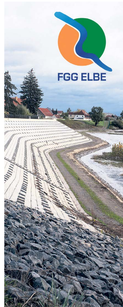
Die mit Verkalitsteinen verstärkte Böschung an der Alten Elbe in Mühlberg/Elbe.
