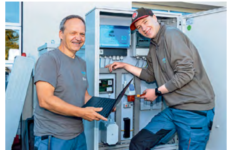
Elektromeister Mario Braatz mit dem ersten MWA-Azubi zum Elektroniker für Betriebstechnik Marlon Berger an einem Schaltschrank. Foto: SPREE-PR/Petsch
